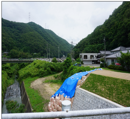
平成30年災害の改修中の塩田地区大前川周辺
